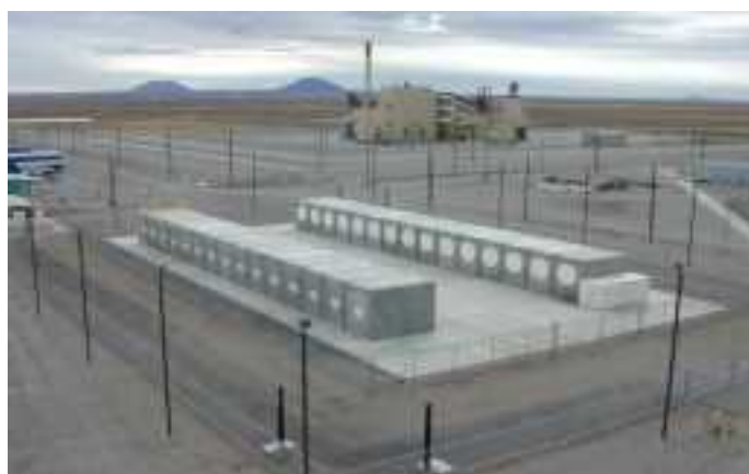
図 2.4-4 NUHOMS-12T : TMI-2 独立使用済み燃料貯蔵施設 (ISFSI) (34)
