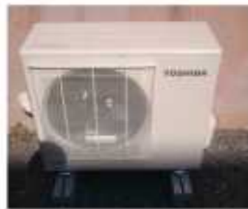
ヒートポンプユニット
