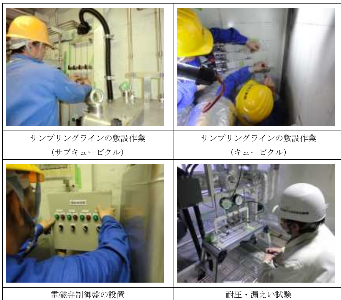
図 4.3.7-1 サンプリングラインの敷設作業の写真
