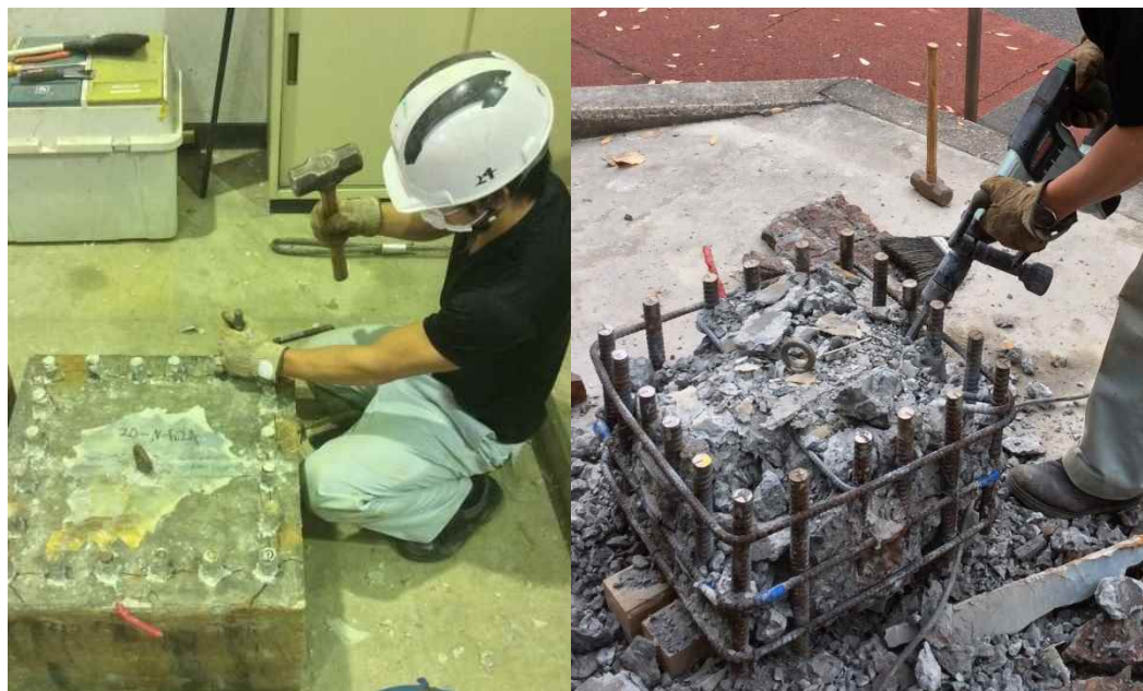
図 2.6.1-4 鉄筋の取り出し
