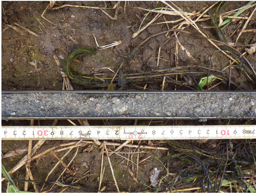
図 5-20 Songji-Ho における掘削状況
