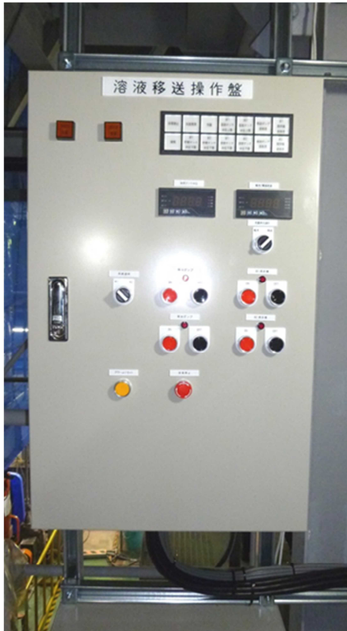
图 3-3 溶液移送操作盤据付状况写真
