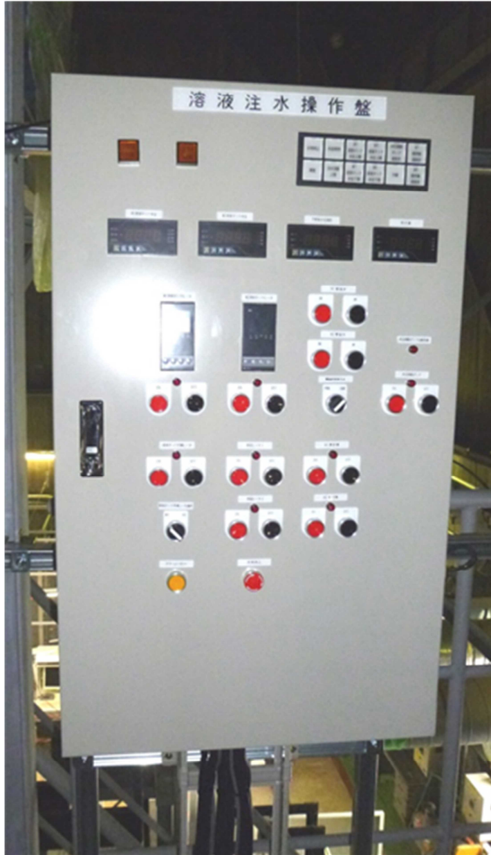
图 3-4 溶液注水操作盤据付状况写真
