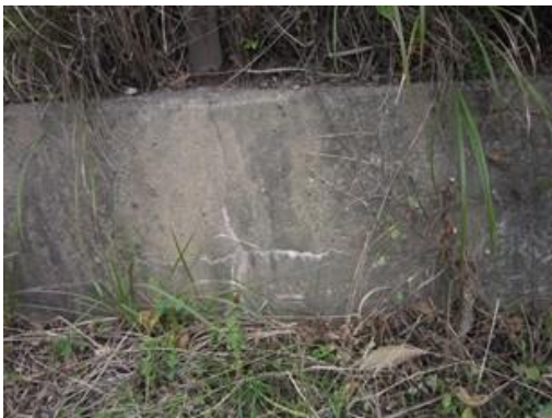
(e) 周辺構造物 A(土留壁)
