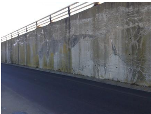
(j) 周辺構造物 F (道路側壁)
