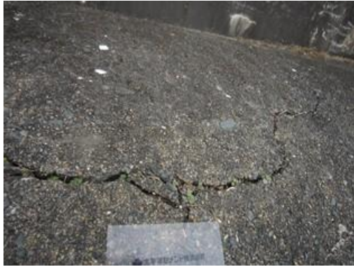
(g) 構造物 B に生じたひび割れ(3~5mm) (h) 構造物 B 風化浸食された緑色片岩の骨材が認められる
