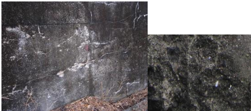
(g) 周辺構造物 B(よう壁) 何れの構造物も粗骨材は石灰石であり、かつ、細骨材は海砂であり細骨材が反応したと推定される
