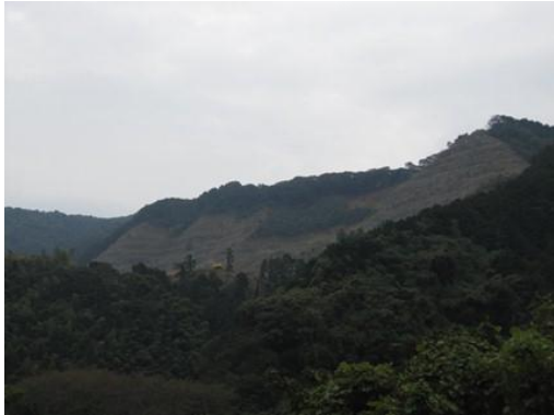
(a) 採石場全景
