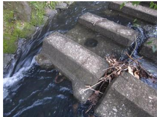
(i) 周辺構造物 D (河川敷ブロック)
