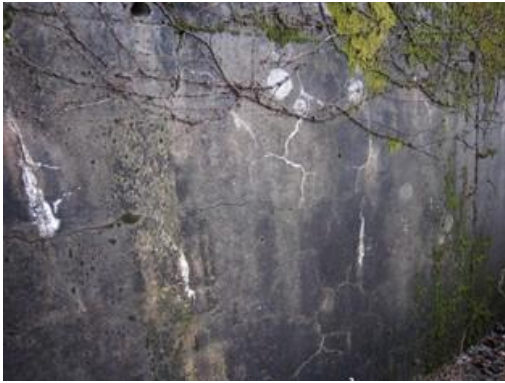
(e) 周辺構造物 A (坑道トンネル入口)
