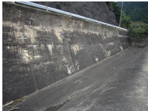
(f) 周辺構造物 B(ダム)
