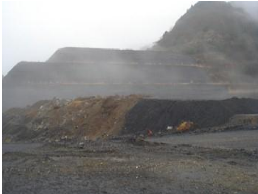
(a) 採石場全景
