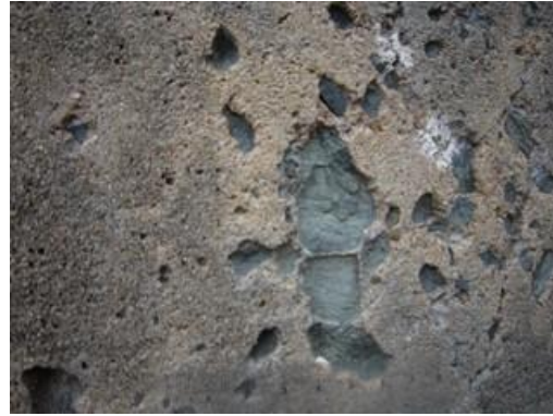
(g) 構造物 B に生じたひび割れ(3~5mm) (h) 構造物 B 風化浸食された緑色片岩の骨材が認められる
