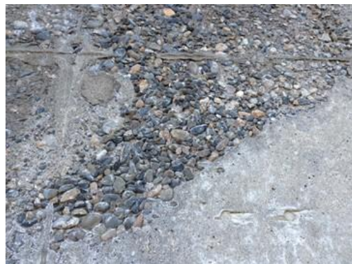
(k) 周辺構造物 F の拡大(採石場と同様の骨材が使用)
