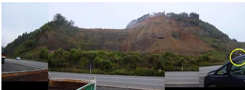
(a) 採石場全景
