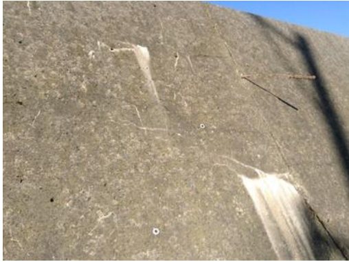
(h) 周辺構造物 D (防波堤)
