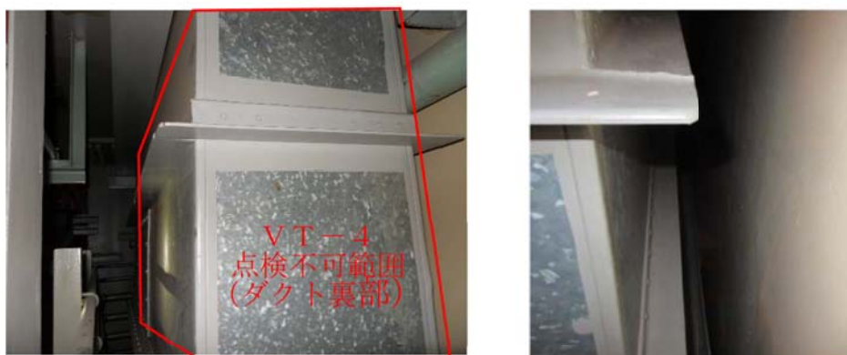
図5.1 VT-4の要求条件が確保できない箇所の例
