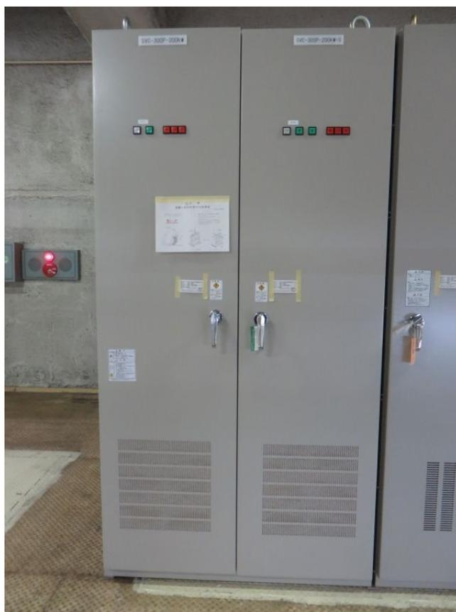
図 4.2.2-9 電力調整装置(サイリスタ盤)
