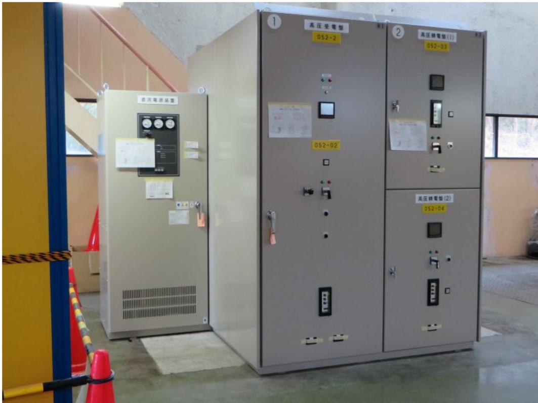
図 4.2.2-5 左から、直流電源装置・高圧受電盤・高圧饋電盤
