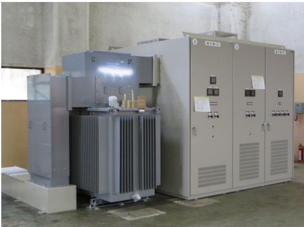
図 4.2.2-6 左から、変圧器・動力盤(1)・動力盤(2)
