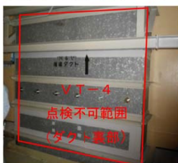
干渉物裏（ダクト裏）
