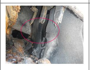
一次側垂直母線の破損 (アーク発生箇所)
