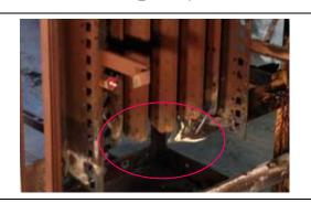
破損した垂直母線(アーク発生箇所)
