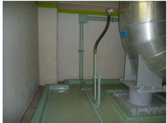
タービン建屋 内壁及び床
