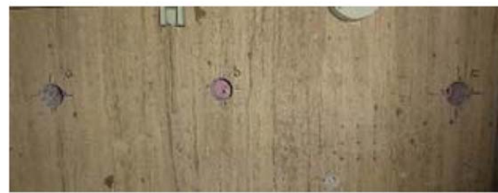
中性化の点検状況
