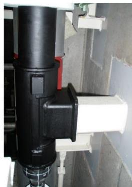
配管破損時の蒸気漏えい量を制限するため、防護カバーを設置
