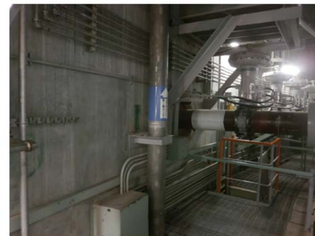
原子炉格納施設等 外部遮蔽壁(1号炉)
