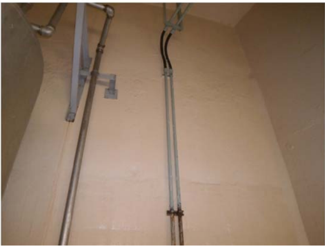
原子炉格納施設等 基礎マット(1号炉)
