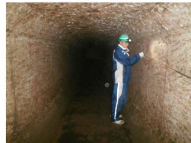
非常用海水路(1号炉)
