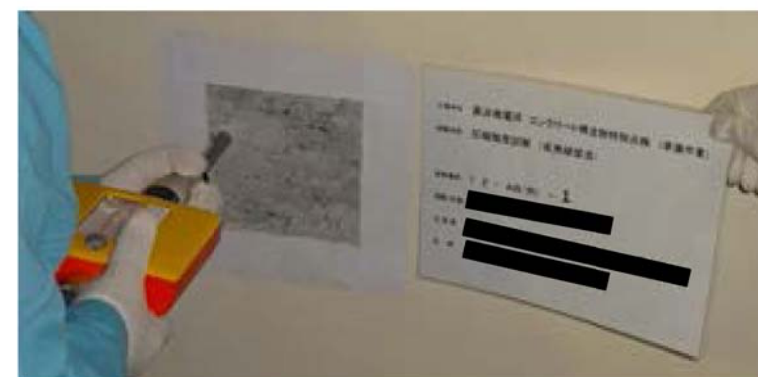
リバウンドハンマーによる試験状況
