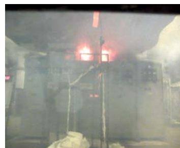
図 20 高圧電源盤の延焼試験
