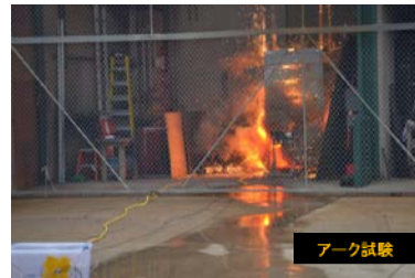
図 13. 配電盤のアーク試験 Fig.13 Arc test status of Distribution Panel
