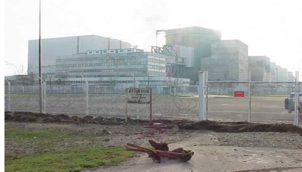
図 3. ルブレイエ原子力発電所の北西ゲート (1999. 12. 28, 2AM までアクセス不可)
