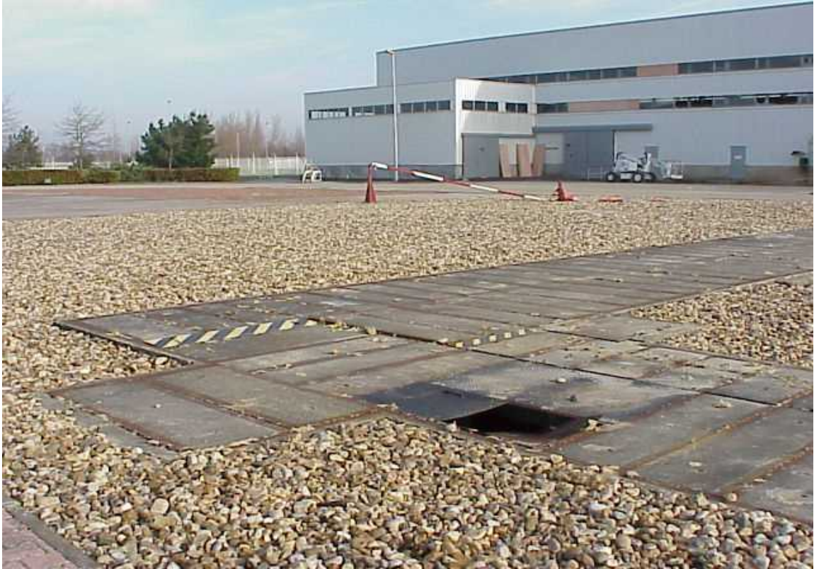
図 8 所内主地下道をおおう鋼板
