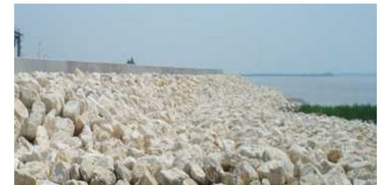
図 8. 改良後の防護堤防
