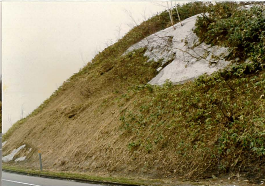
南側法面状況。北側法面と同様に植生で保護されている。
