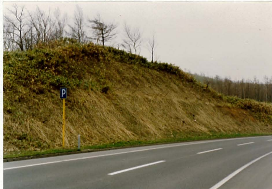
北側法面状況。植生で保護されている。
