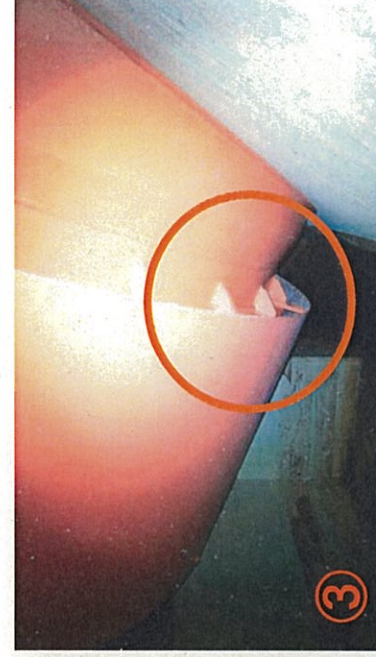
ベント管ベローズカバー下部
