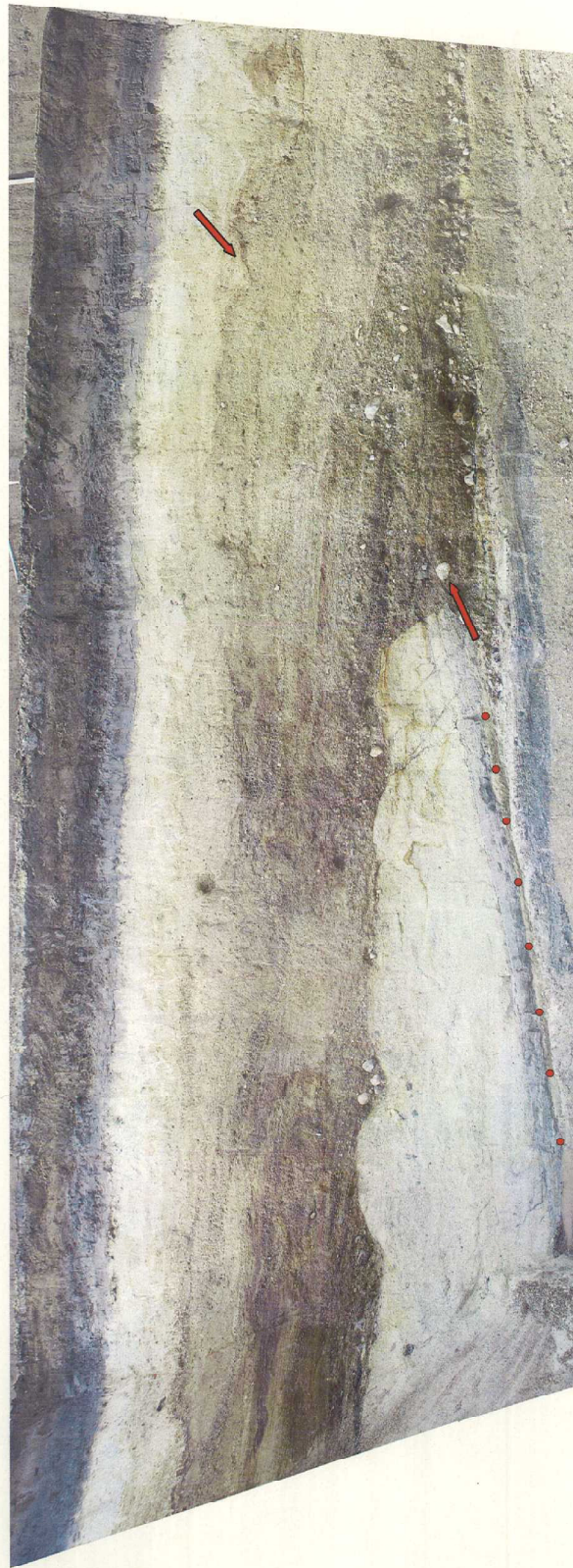
8m西方法面画像
