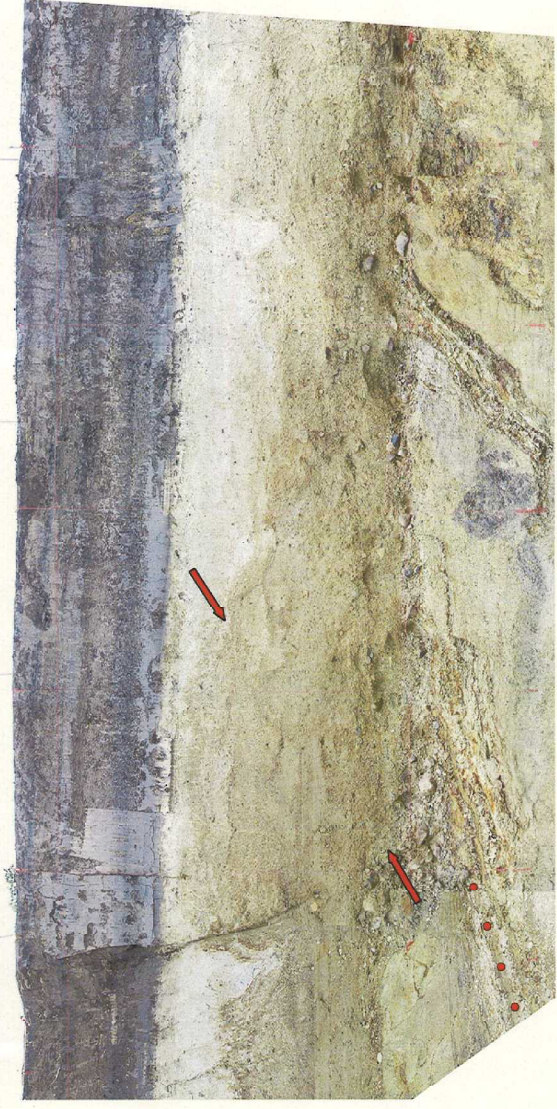
17m西方法面画像
