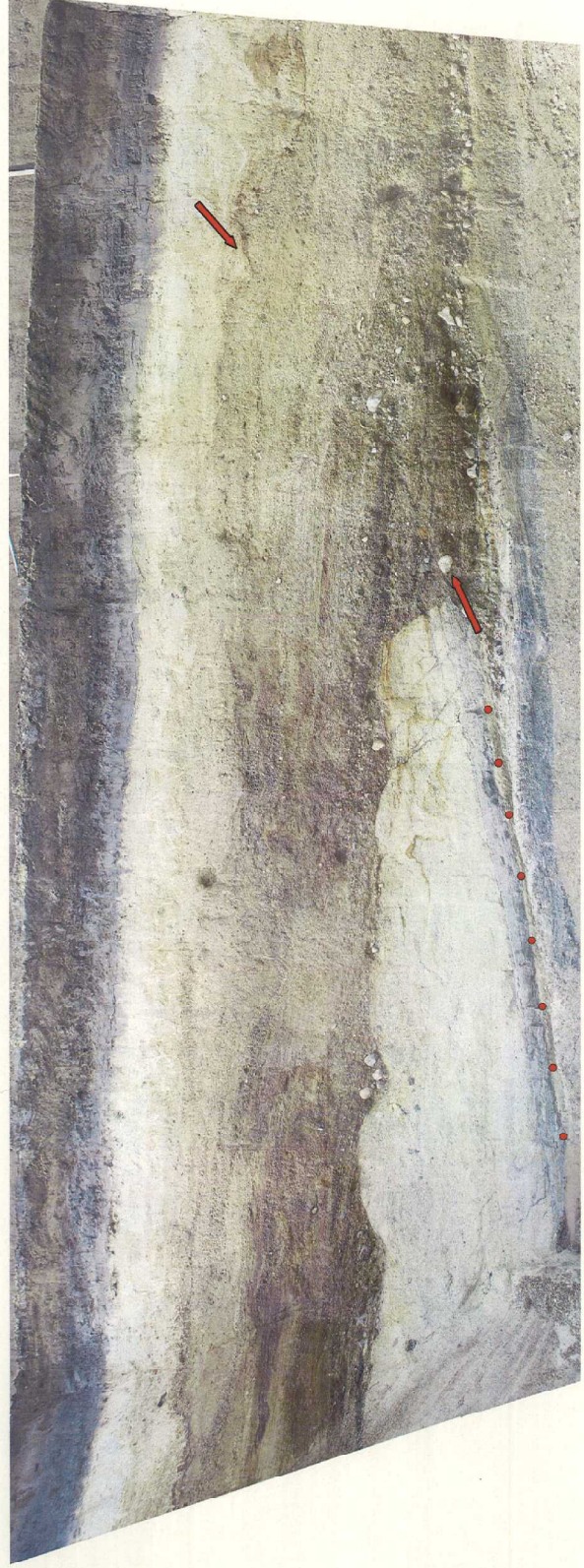
8m西方法面画像
