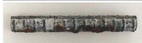
No.1 (腐食グレードII)
