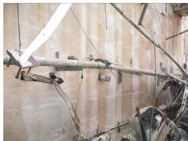
②プール壁異常なし
