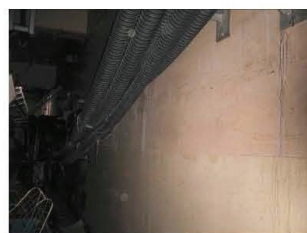
②プール壁異常なし
