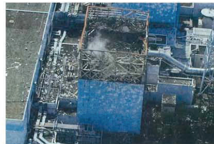
図-3.1 1号機原子炉建屋の損傷状況（立面図）
