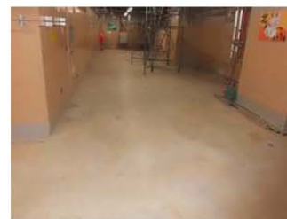
地下1階（撮影日：平成24年12月9日）
