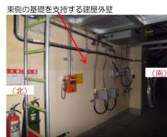
⑤基礎設置部（東側、内部）
