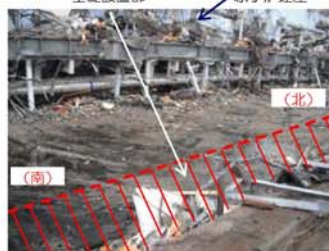
④基礎設置部（東側、外部）
