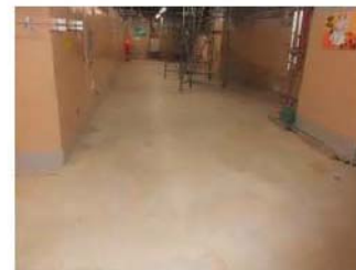
地下1階 (撮影日: 平成24年12月9日)
