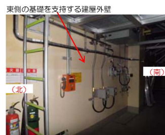
⑤基礎設置部（東側、内部）
