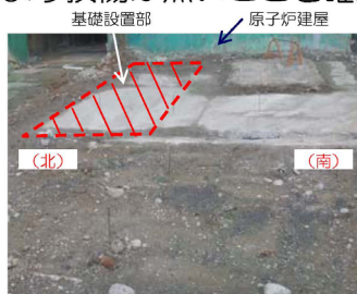
③基礎設置部（西側）
