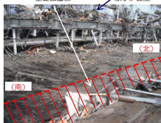
④基礎設置部（東側、外部）
