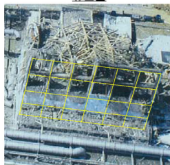
②東面 外壁
