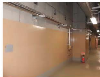
2階（撮影日：平成24年12月9日）
