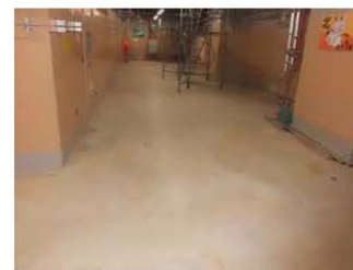
地下1階（撮影日：平成24年12月9日）
