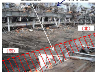
④基礎設置部（東側、外部）
