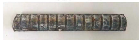
No.2 (腐食グレードI)
