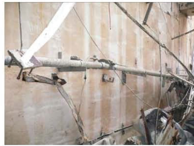
②プール壁異常なし
