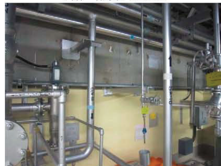
3 階 西側燃料プール壁
