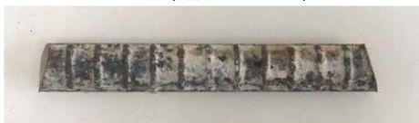
No.3 (腐食グレードI)
