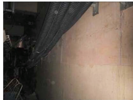
②プール壁異常なし
