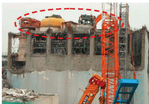
(a) オペフロ上部の機器
