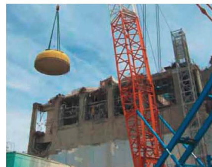
(b) 機器の撤去作業
