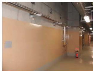
2階（撮影日：平成24年12月9日）
