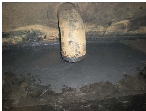
底板ドレン配管近傍
