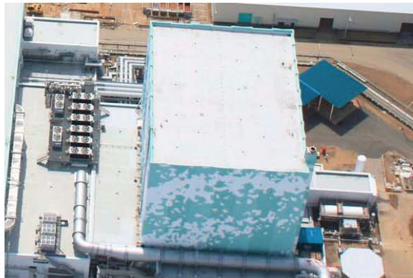
図-1.1 外観写真(北面、3月24日撮影)
