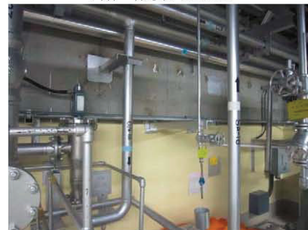
3 階 西側燃料プール壁
