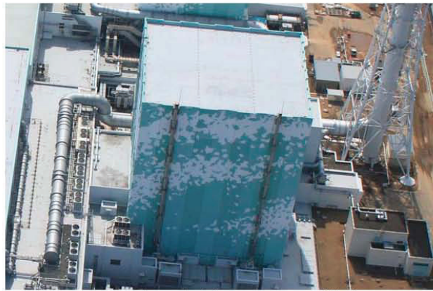
図-1.1 外観写真(北面、3月24日撮影)
