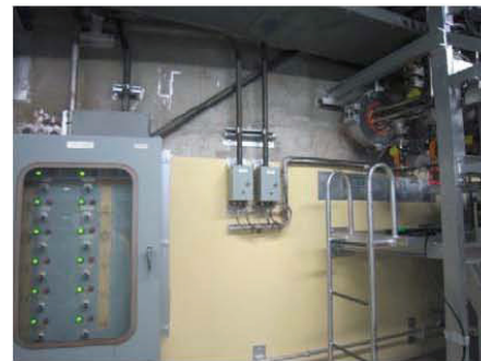
1 階 南側シェル壁
