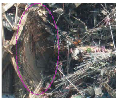
機器仮置プール西側壁の状況が確認できる部分 図-2.2 機器仮置プール西側の壁の状況
