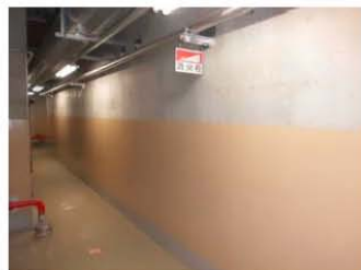
1階（撮影日：平成24年12月9日）
