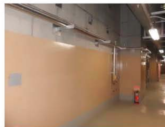
2階（撮影日：平成24年12月9日）
