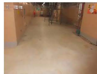
地下1階（撮影日：平成24年12月9日）
