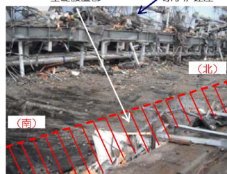
④基礎設置部（東側、外部）
