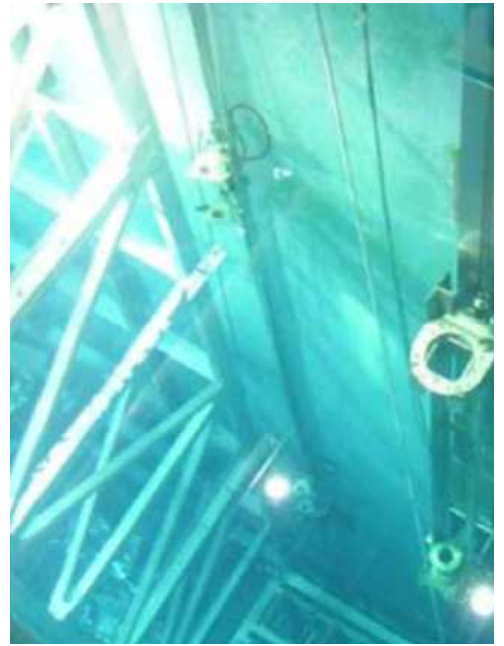
図 2-1 原子燃料工業株式会社熊取事業所の燃料昇降機（FPM）
