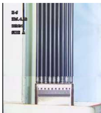
A面からの燃料棒外観確認
