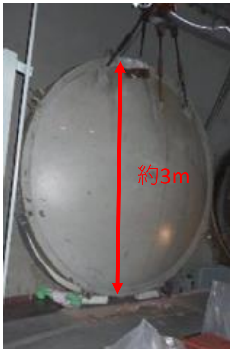
機器搬入口 (1号機の例)
