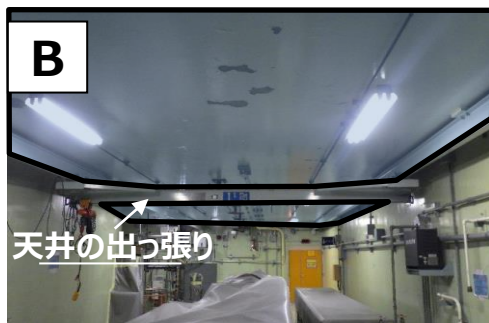
気体の移行を妨害する天井の出張り（小部屋（CRD補修室））
