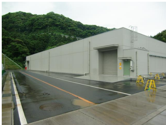
固体廃棄物貯蔵所D棟
