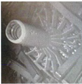
【原子炉格納容器内】
