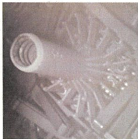
【原子炉格納容器内】
