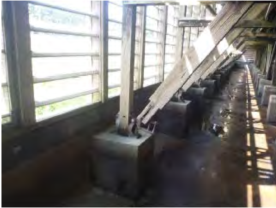
図①-1 冷却塔の筋かい補修前の写真
