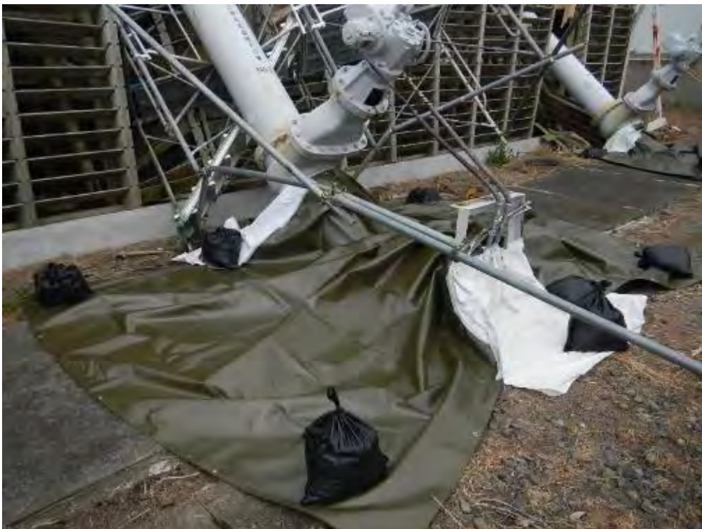
写真⑥ 二次冷却系配管 (No.3 セル側) 養生後 (令和元年9月11日撮影)
