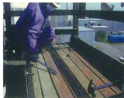
階段踊り場補修
