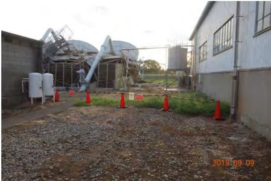
写真① 冷却塔 東側（令和元年9月9日撮影）
