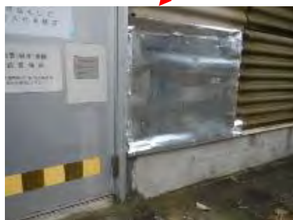
写真③ 補修後(1)（令和元年 9 月 9 日撮影）
