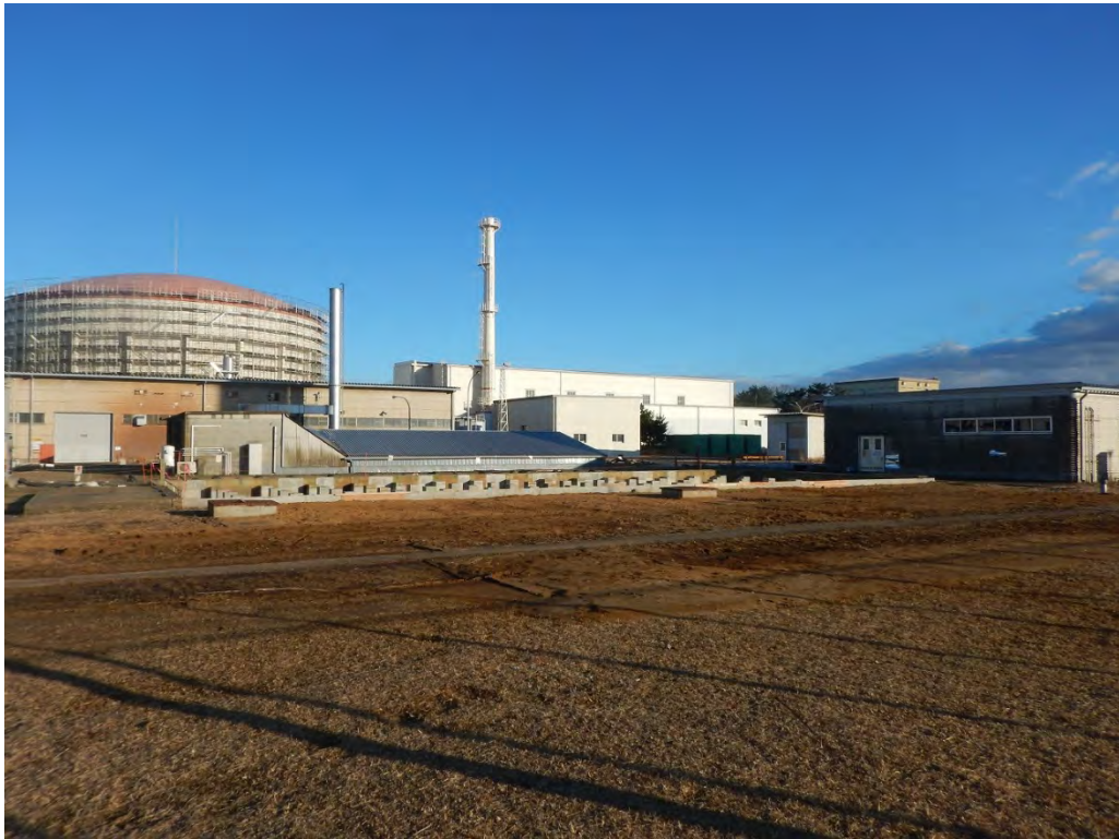
写真⑦ 撤去後状況(西側) (令和2年1月31日撮影)
