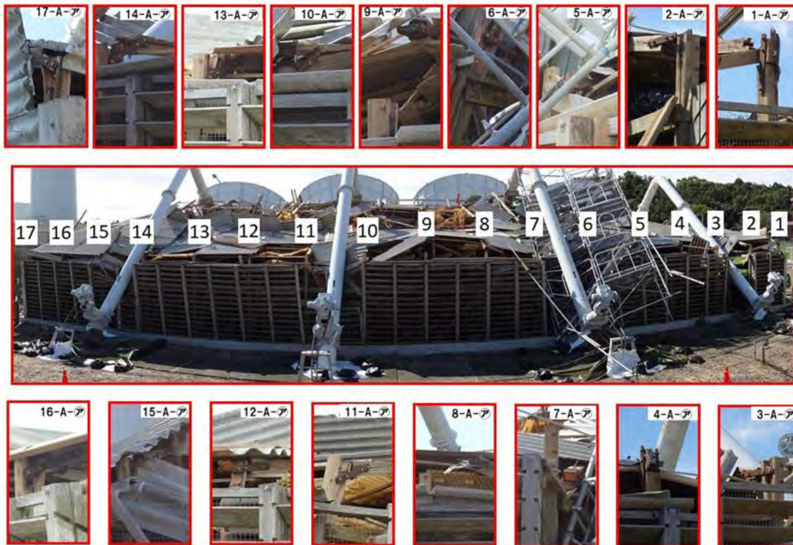
図④-2 冷却塔の東面における柱接合部の調査
