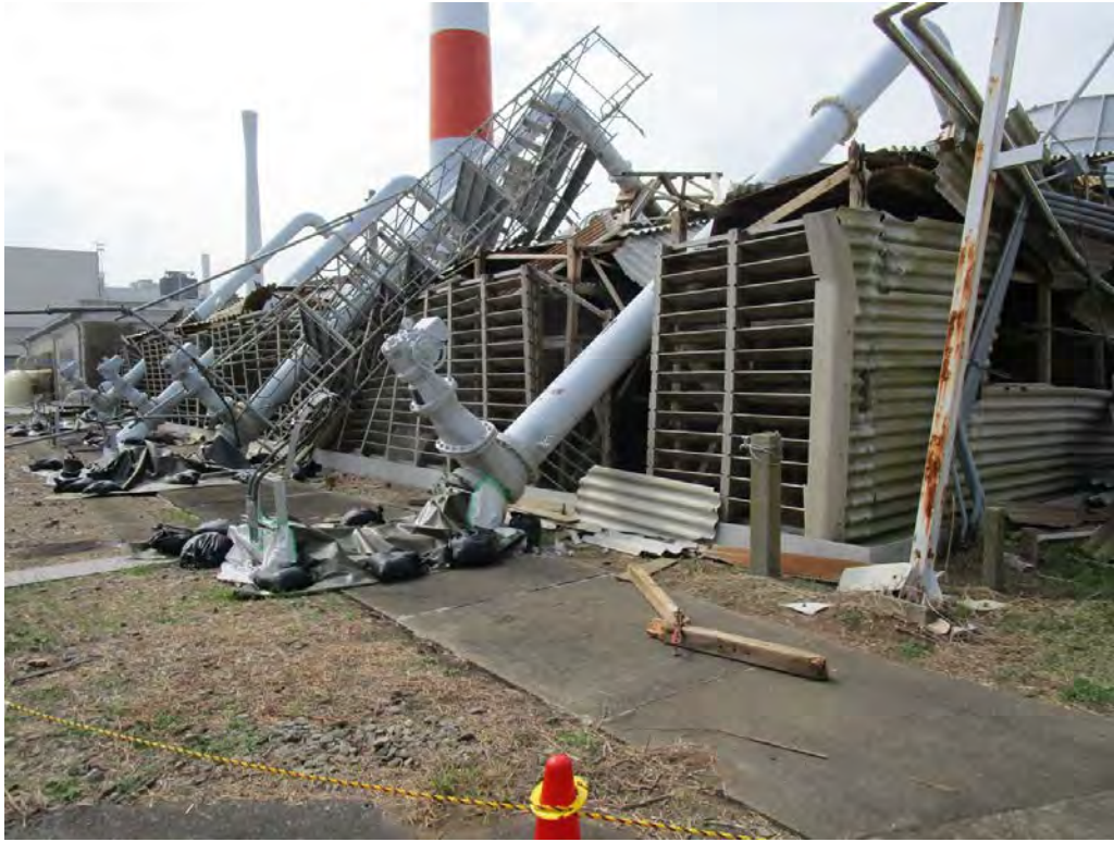
写真③ 撤去前状況(東側) (令和元年10月3日撮影)
