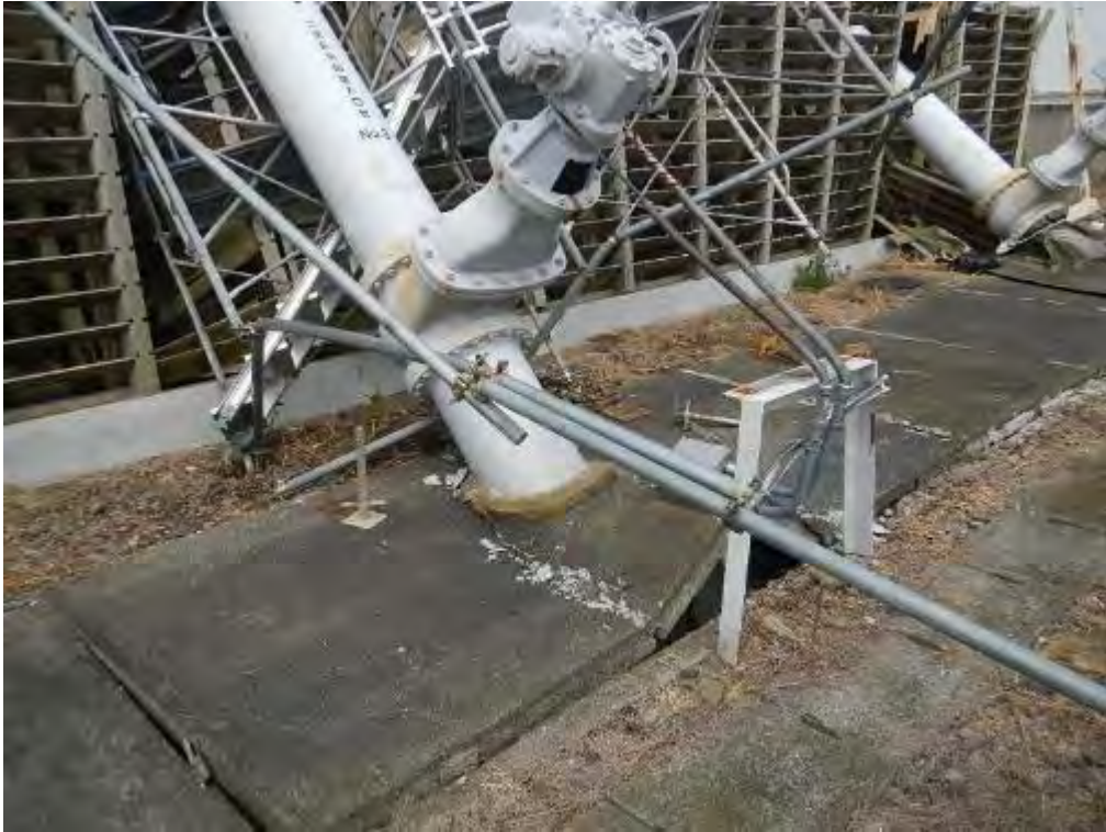
写真⑤ 二次冷却系配管 (No.3 セル側) 養生前 (令和元年9月11日撮影)
