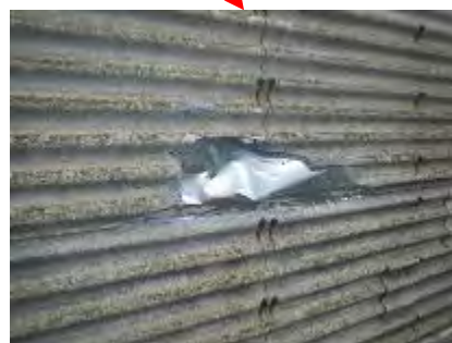
写真④ 補修後(2)（令和元年 9 月 9 日撮影）
