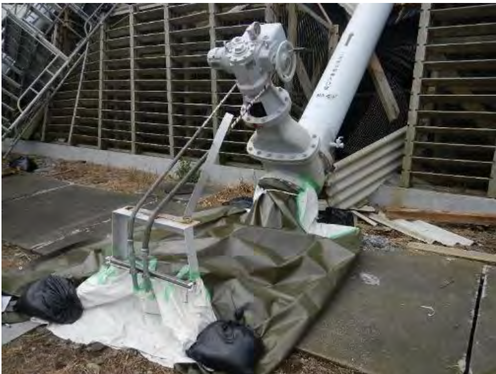
写真⑧ 二次冷却系配管 (No.4 セル側) 養生後 (令和元年 9 月 11 日撮影)
