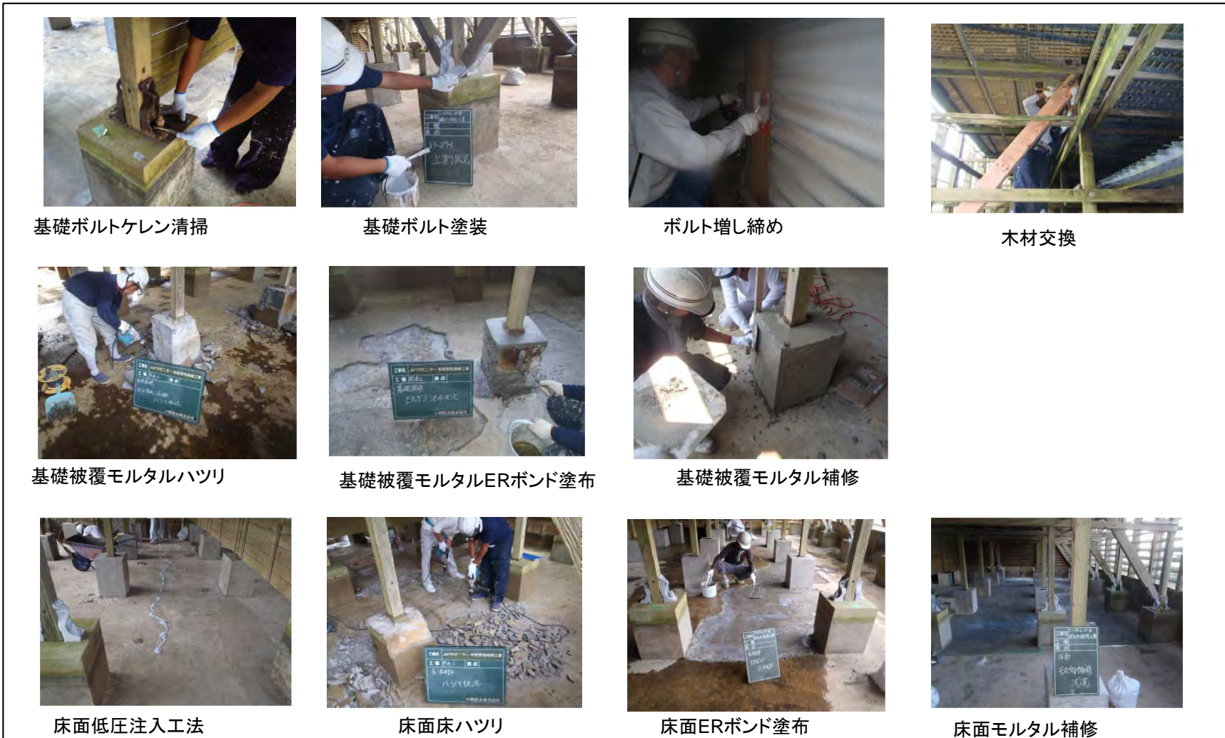
(5) 平成 24 年 9 月の交換・補修作業 その 2
