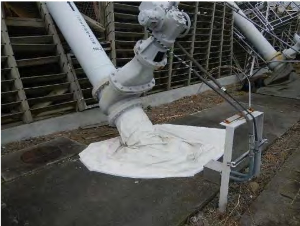
写真④ 二次冷却系配管 (No.2 セル側) 養生後 (令和元年9月11日撮影)
