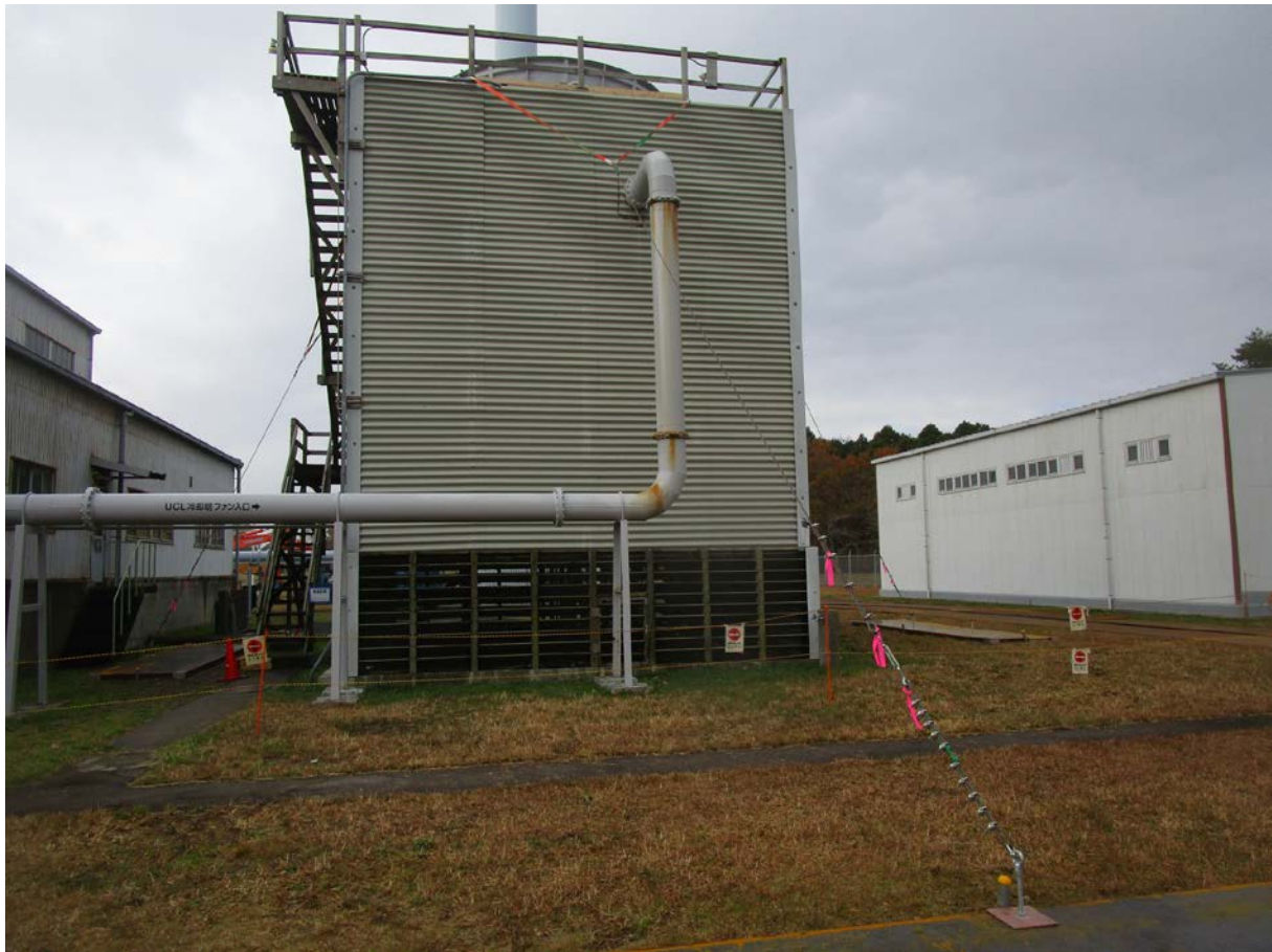
図7 UCL 系統冷却塔：ワイヤーロープによる固定（令和元年 11 月 25 日撮影）
