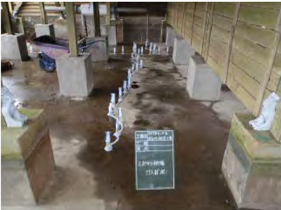
図⑩-4 低圧注入工法による補修時の写真
