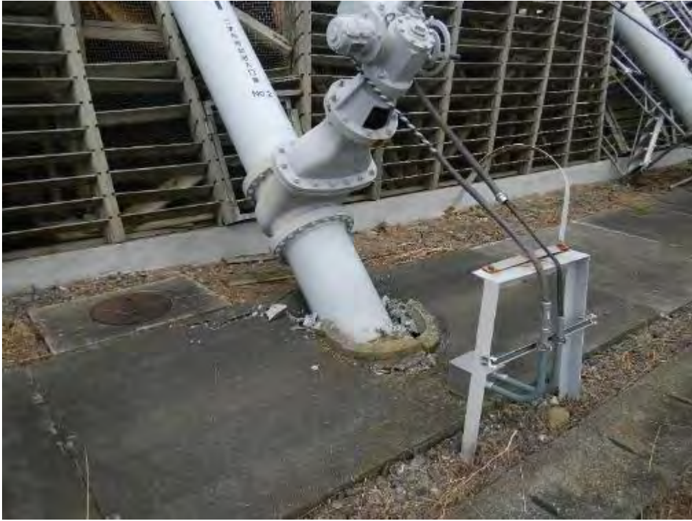
写真③ 二次冷却系配管 (No.2 セル側) 養生前 (令和元年9月11日撮影)
