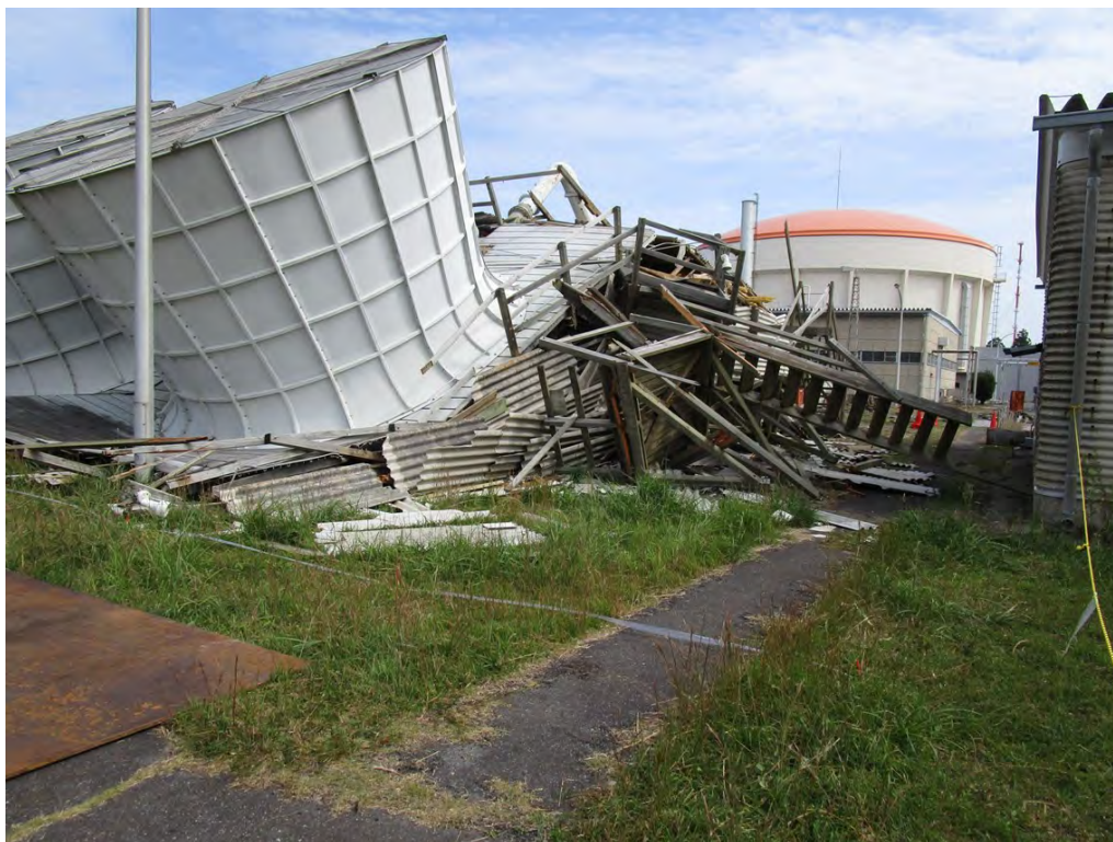
写真① 撤去前状況(南側) (令和元年10月7日撮影)
