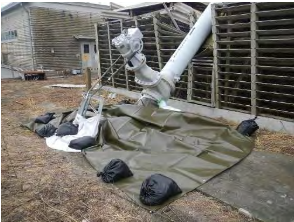
写真② 二次冷却系配管 (No.1 セル側) 養生後 (令和元年9月11日撮影)
