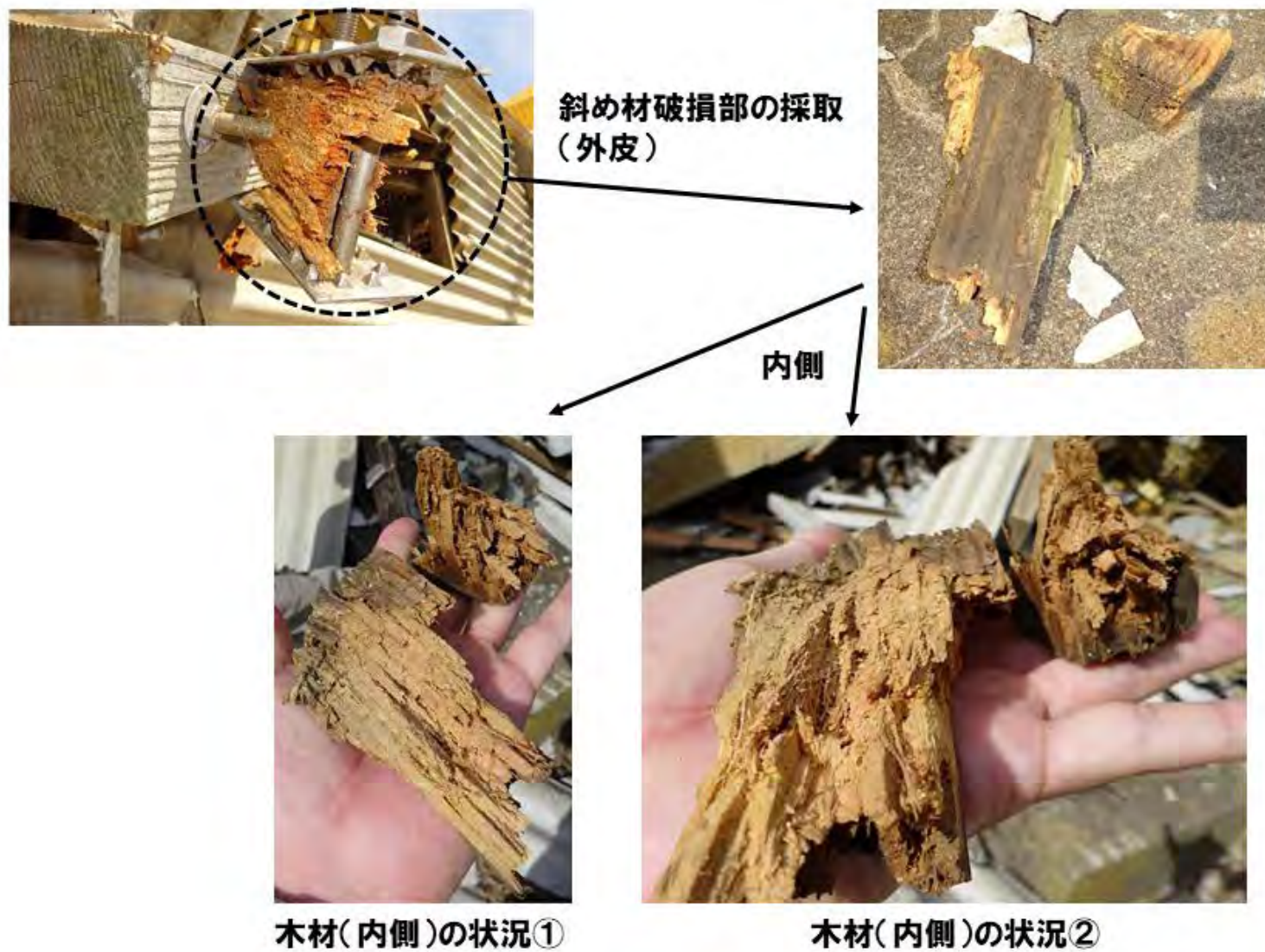
図④-8 南面の階段斜め材の木材の状況
