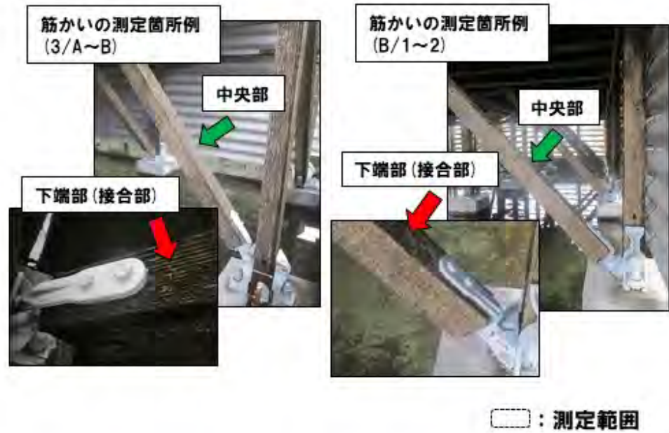
(b) 針貫入試験の測定箇所
