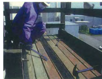
階段踊り場補修
