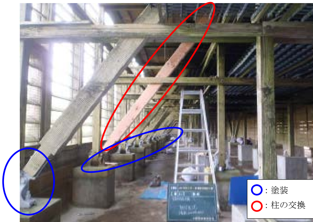
図①-2 冷却塔の筋かい補修後の写真
