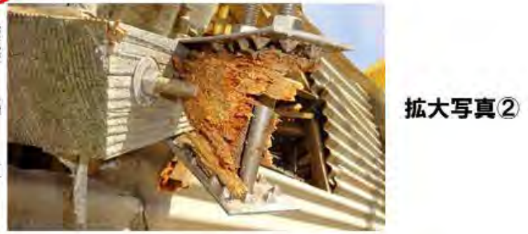
図④-7 冷却塔の南面における柱接合部等の詳細調査箇所
