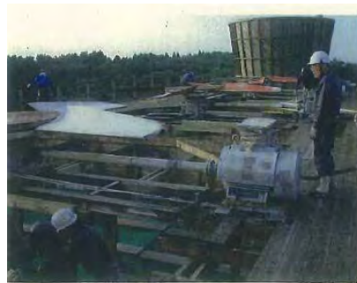
デッキ取外し
