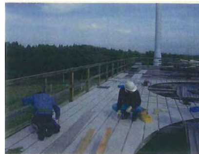
デッキFRP交換
