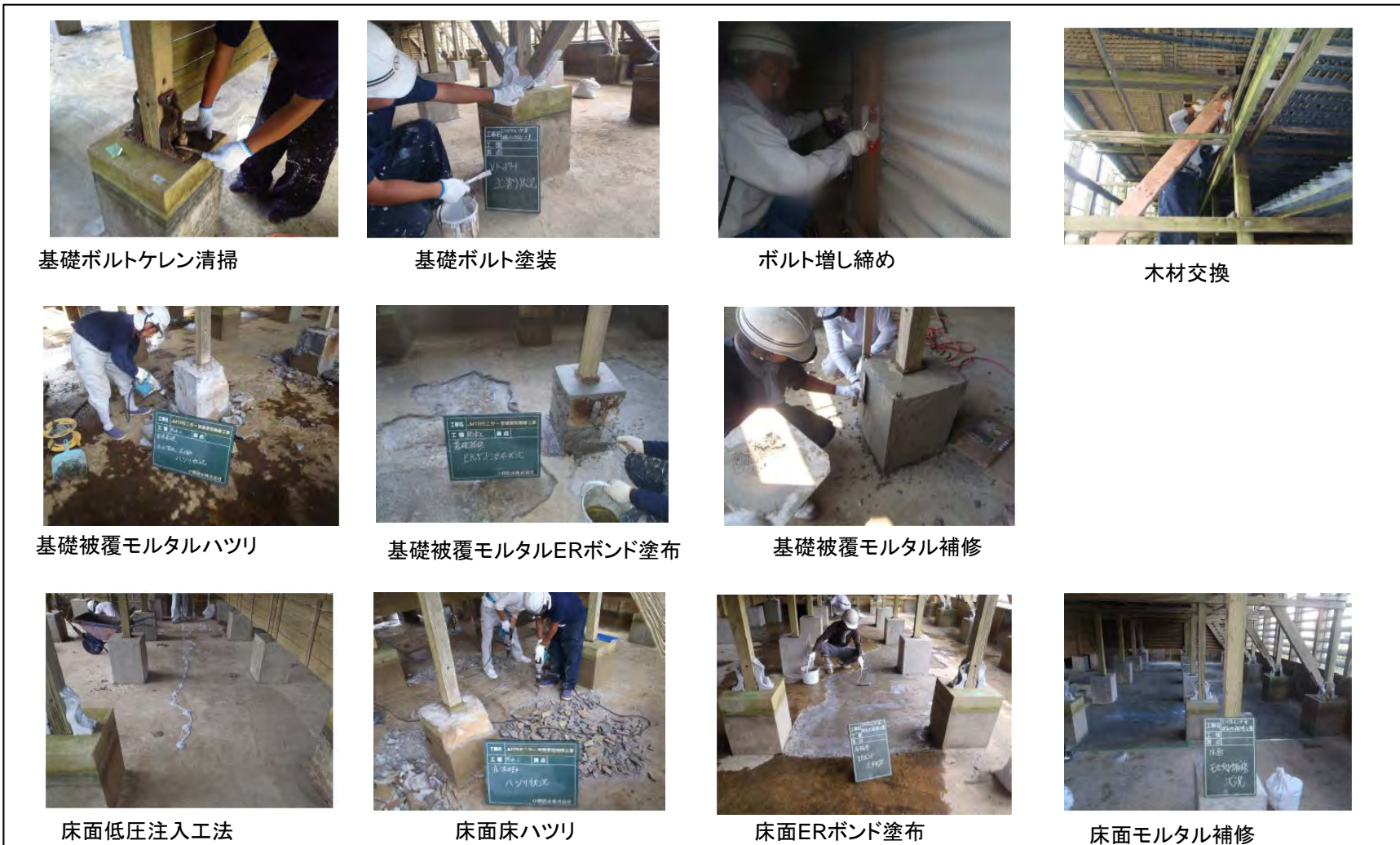
(5) 平成 24 年 9 月の交換・補修作業 その 2
