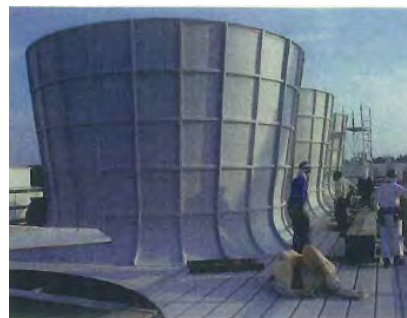
ファンスタックFRP交換
