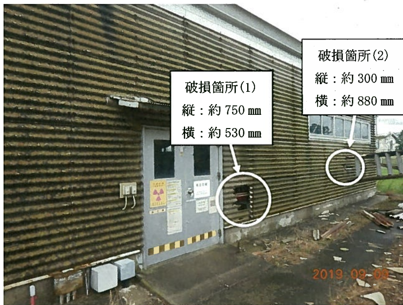
写真① 補修前（令和元年9月9日撮影）
