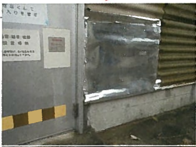
写真③ 補修後(1)（令和元年9月9日撮影）
