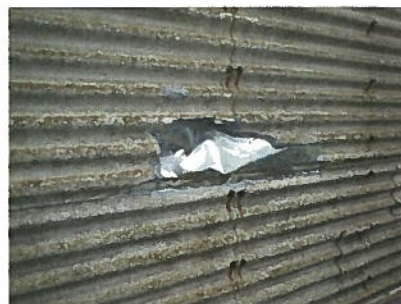
写真④ 補修後(2)（令和元年9月9日撮影）
