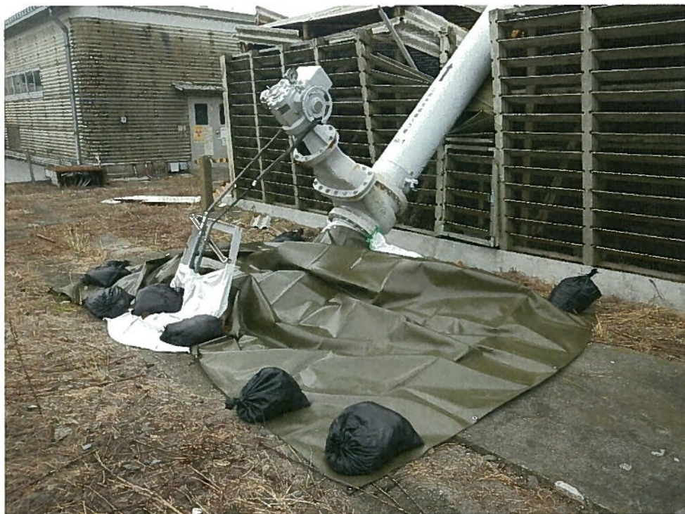
写真② 二次冷却系配管 (No.1 セル側) 養生後 (令和元年9月11日撮影)
