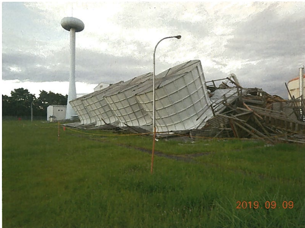
写真② 冷却塔 西側（令和元年9月9日撮影）
