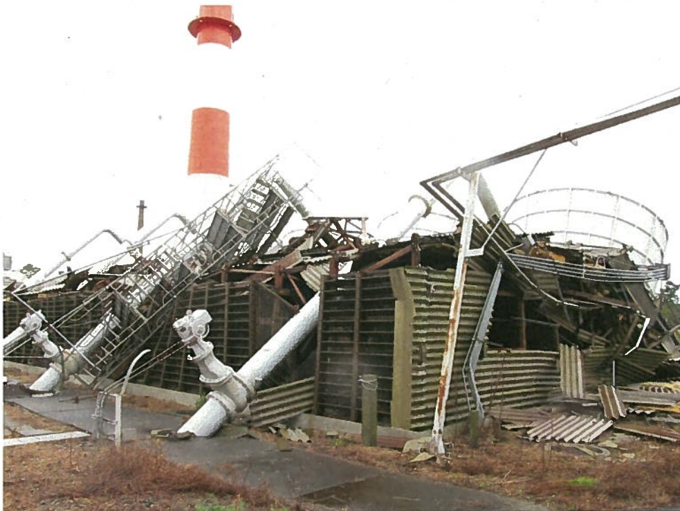
写真② 倒壊後（令和元年9月9日撮影）
