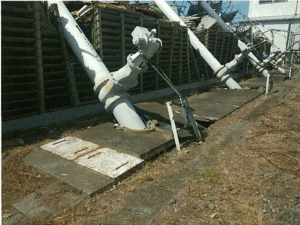
写真① 二次冷却系配管 (No.1 セル側) 養生前 (令和元年9月11日撮影)
