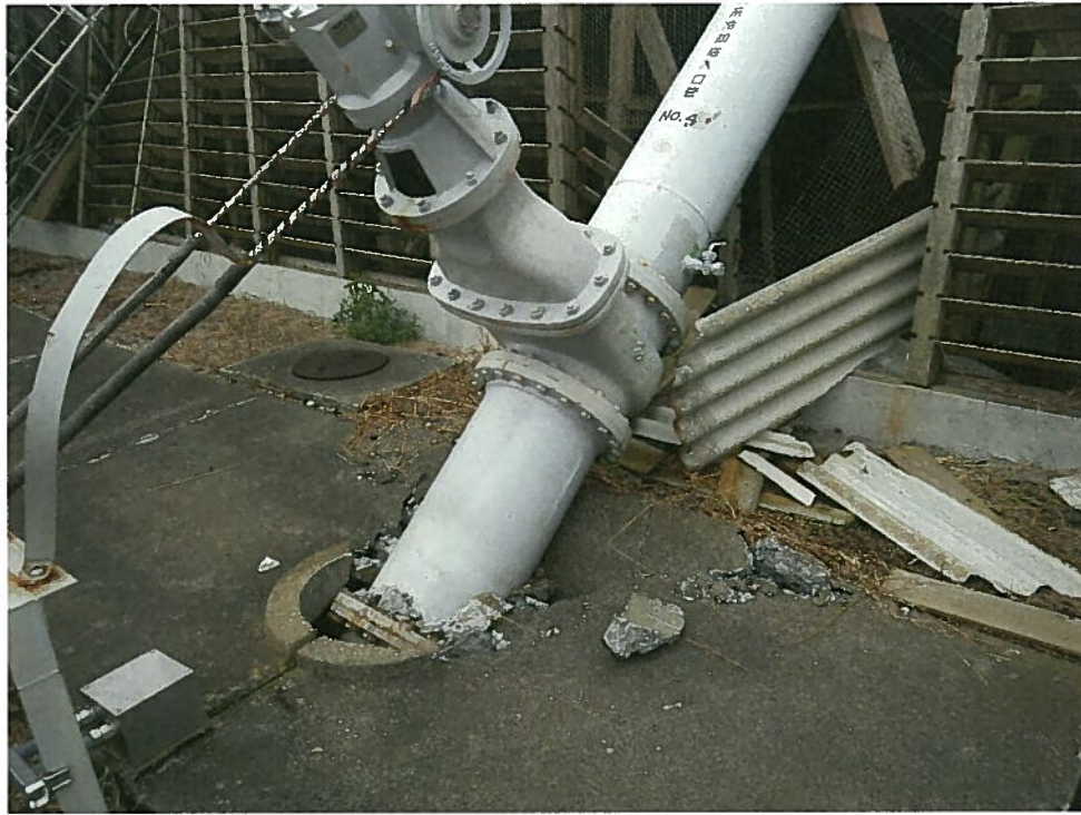
写真⑦ 二次冷却系配管 (No.4 セル側) 養生前 (令和元年 9 月 11 日撮影)
