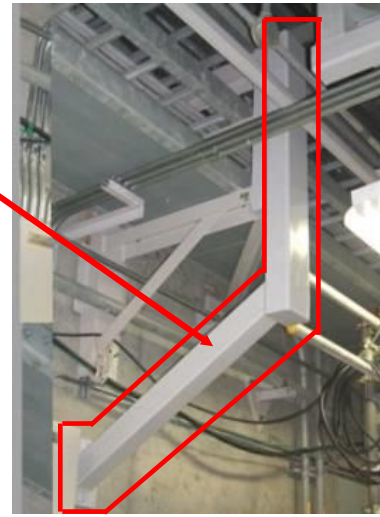
(改造後) 原子炉建屋(原子炉格納容器外)
