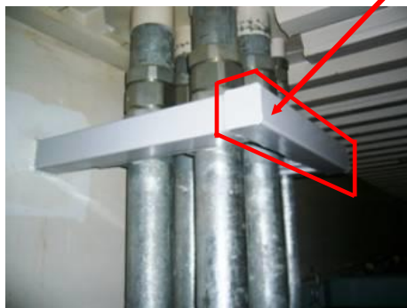
(改造後) 原子炉建屋(原子炉格納容器外)
