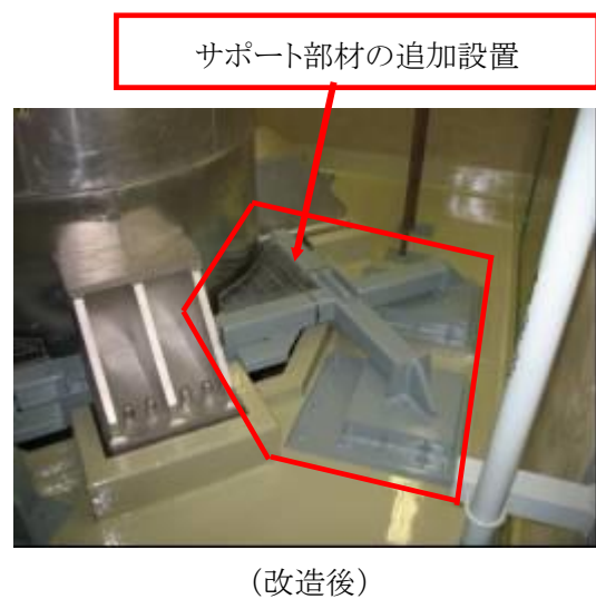
余熱除去系熱交換器サポートの改造例
