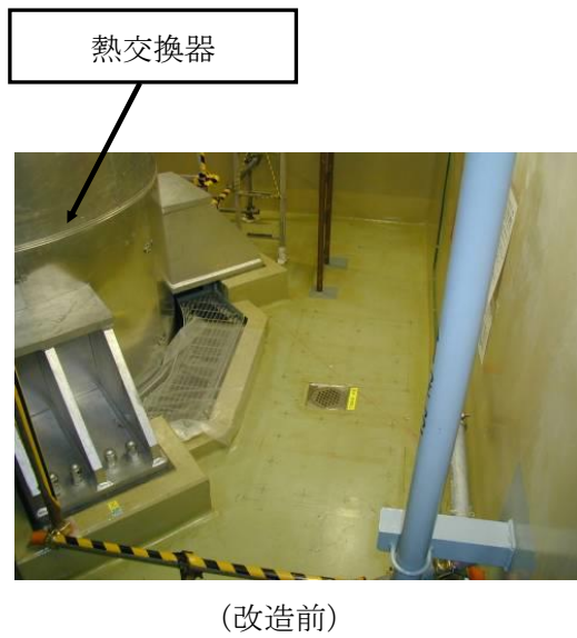
余熱除去系熱交換器サポートの改造例
